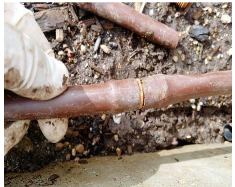
Inserte el acoplamiento y vuelva a colocarlo
